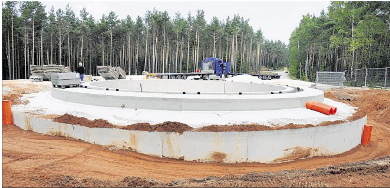
Auf dem Hahnenkamm bei Edelsfeld ist bereits das Fundament der Enercon-Windkraftanlage betoniert. Kommen- de Woche soll der Bau des Turmes beginnen. Bild: Huber
