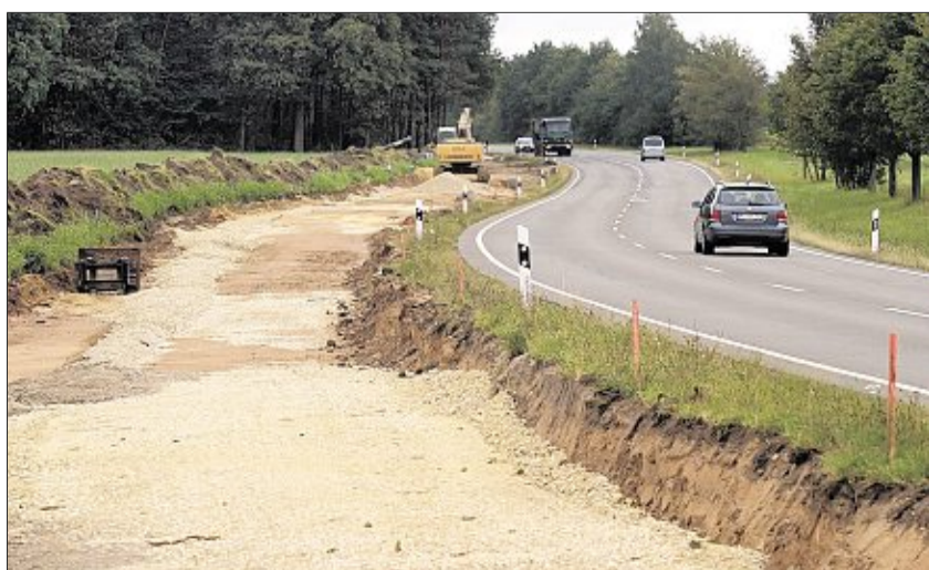
Der Radweg wird drei Meter breit und kann deshalb auch als Wirtschaftsweg genutzt werden. Bild: Steinbacher
