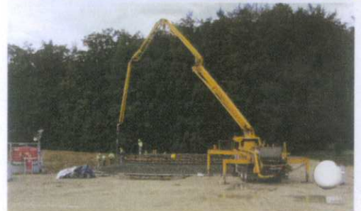
Oben: Giessen des Fundaments Unten: Gegossenes Fundament
