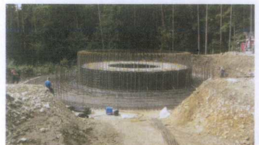
Oben: Aufbau des Fundaments Unten: Das Fundament
