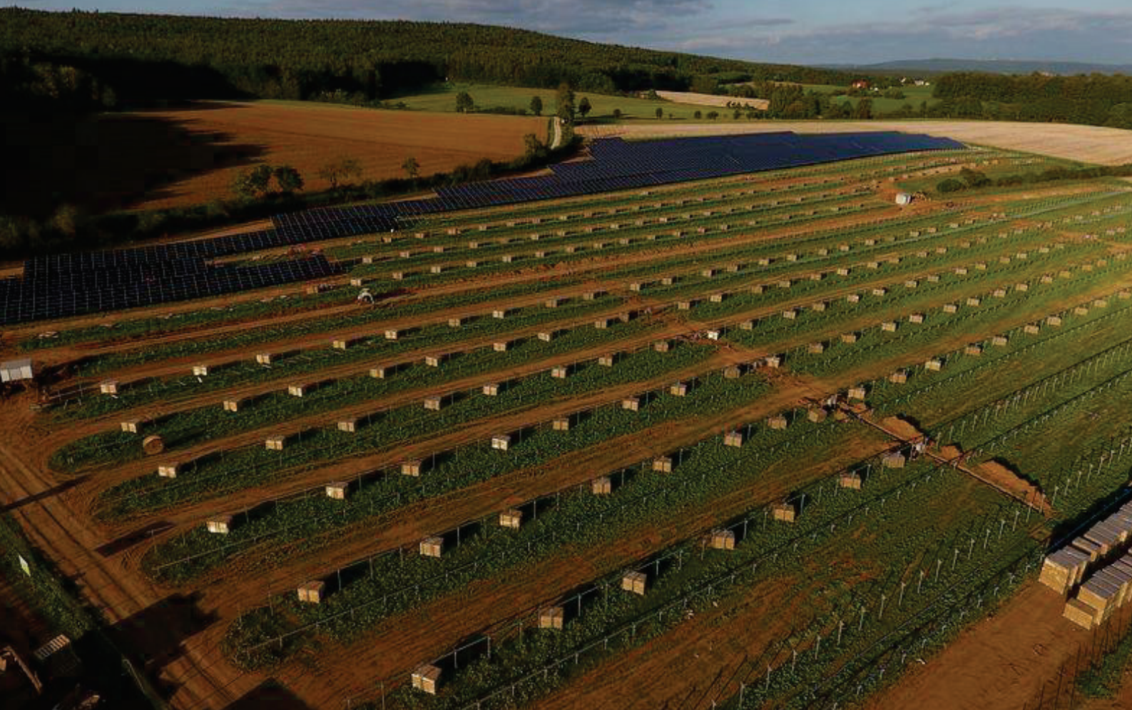
Bürgersonnenenergie Röbersdorf (Bauphase)
